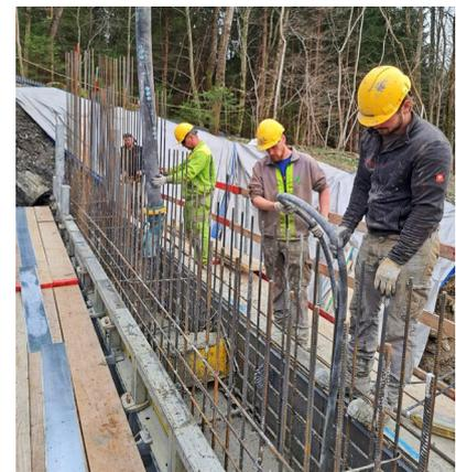
Betonierarbeiten zur Errichtung einer neuen Konsolidierungssperre zur Sicherung der Grabeneinhangs des Weinzierlbaches. Fotos: WLVL Gebietsbauleitung Oberösterreich Ost)
